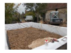
Le substrat d'une épaisseur de 0,60 m se compose de haut en bas de gravillons et de graviers d'une surface totale de 27 m2.
