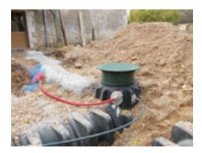
Les deux cuves sont raccordées entre elles le tropplein rejoindra les eaux pluviales Pompe immergée
