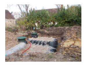
L'eau de pluie se collecte au niveau d'un regard muni d'un tamis assurant le filtrage des grosses particules dans l'eau recueillie.
