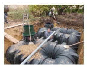
Deux cuves de 7500 litres sont enterrées dans le terrain
